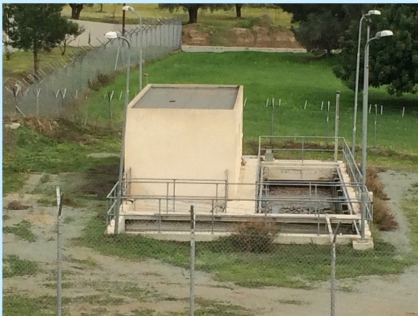
Σταθμός Επεξεργασίας Λυμάτων
